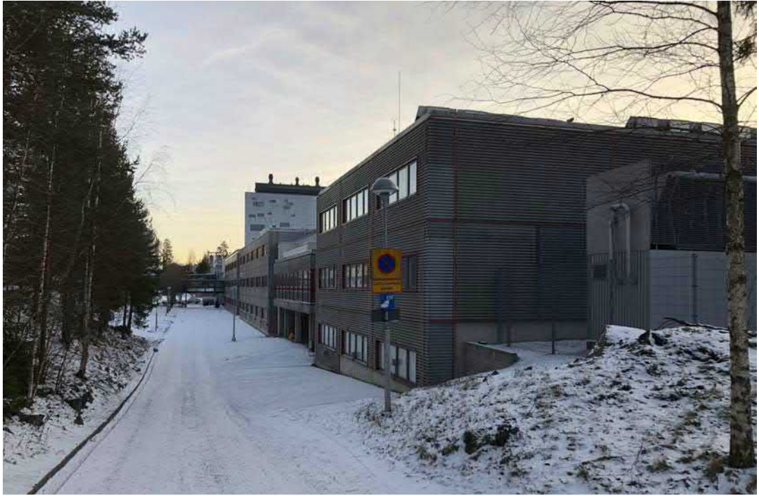
Kuva 26. Sähkötalon itäsivua pohjoisesta katsottuna.
